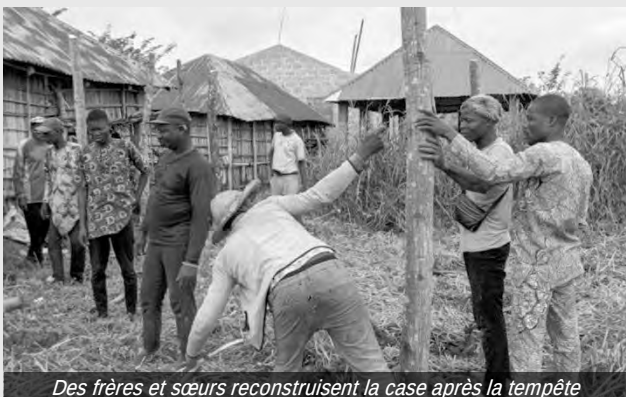
Des frères et sœurs reconstruisent la case après la tempête
